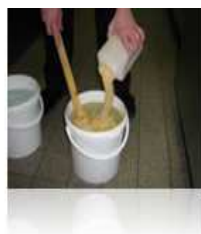
Die Komponente 2 wird mit 12l lauwarmen Wasser gemischt
