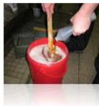
Die Komponente 1 wird mit 12l warmen Wasser gemischt
