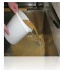
Die Komponente 2 wird auf alle Abläufe verteilt
